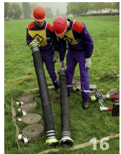
Nach der Befehlswiederholung durch den ATF fordert der Wassertruppführer „Vier Saugschläuche“ an. Der Wassertrupp stellt gemeinsam mit dem Schlauchtrupp die Wasserversorgung von der Wasserentnahmestelle bis zur TS her.
